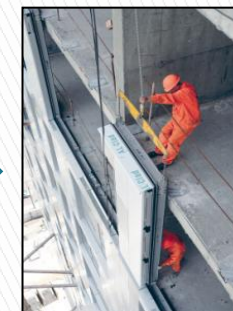
Сборка, транспортировка и монтаж
